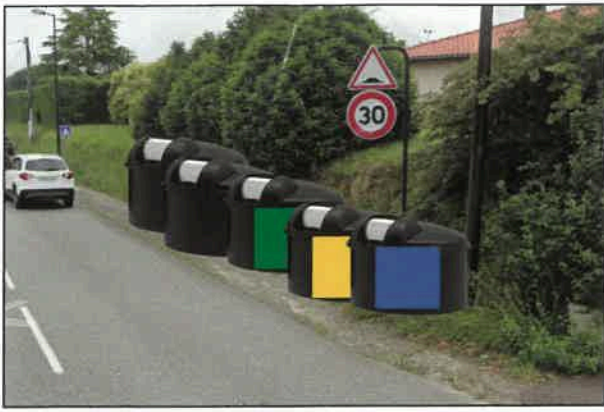
5 AVENUE ABBÉ BORDES Tous les conteneurs sont semi-enterrés
